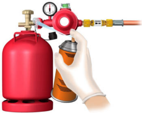
Abbildung 7: Dichtheitskontrolle unter Druck mittels Lecksuchspray
